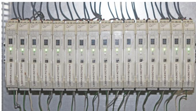
Рисунок 12: Измерительный преобразователь для монтажа на шине
