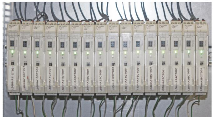
Abbildung 12: Messumformer für Schienenmontage
