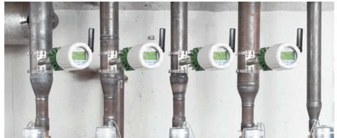
Abbildung 14: Temperaturfühler für Oberflächenmontage und integriertem Energy Harvester
