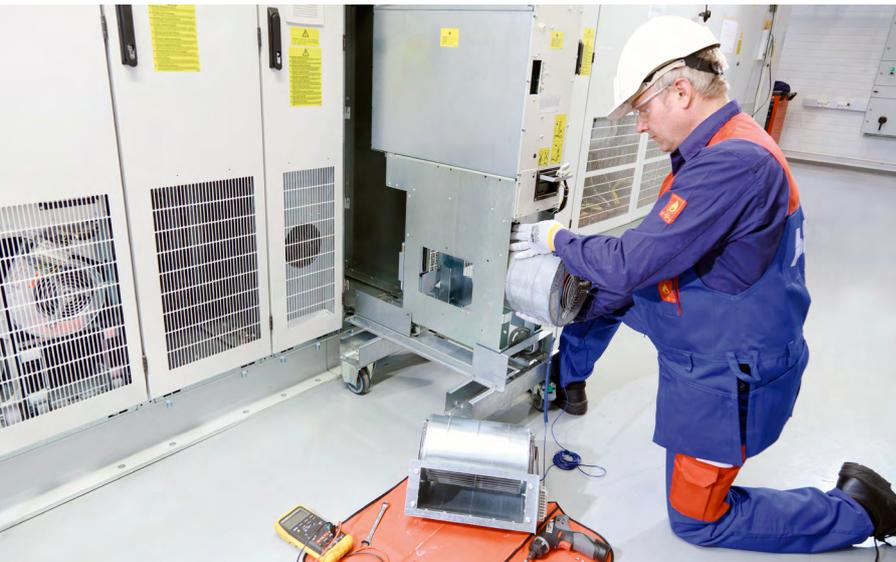
Frequenzumrichter – ob Kompaktgeräte, Module oder Schrankeinheiten – werden entsprechend ihrer Wartungspläne gewartet. Damit bleiben die Wartungskosten unter Kontrolle und die Leistung während der Nutzungsdauer wird optimiert.
