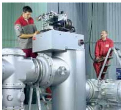
**Links:** Statische Blindleistungskompensatoren (Static Var Compensators) erhöhen die Stromqualität und ermöglichen energieintensiven Unternehmen wie Stahl- oder Aluminiumherstellern eine Steigerung ihrer Produktion.
