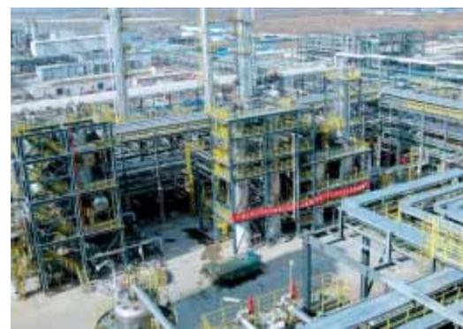
Mit Hilfe der ABB-Technologie erfolgt die Überwachung und Steuerung des CFB-Prozesses, bei dem Brennstoff bei niedrigen Temperaturen unter Zugabe von Kalkstein im Kessel verbrannt wird. Der Prozess zeichnet sich durch eine effiziente Energiegewinnung und niedrige Emissionen aus.
