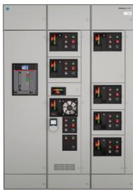
La gamme ReliaGear<sup>MD</sup> LV MCC offre un moyen plus sécuritaire, plus intelligent et plus durable de protéger et de contrôler les moteurs grâce à la technologie de disjoncteurs SACE<sup>MD</sup> Tmax<sup>MD</sup> XT, à ses relais de protection des moteurs UMC 100.3 et à la famille d'entraînements à fréquence variable ACS580.
