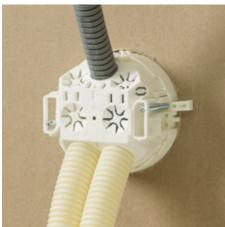
Flexible plastic conduit installation.
