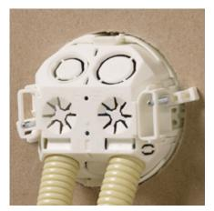
Flexible plastic conduit installation.
