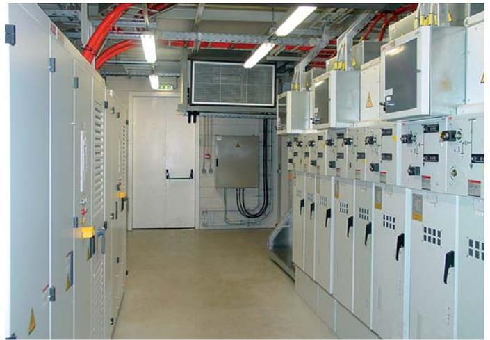
Sala comando con drive a velocità variabile ACS 2000 (a sinistra) e quadro elettrico UniMix (a destra)
