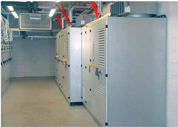
Tre drive a velocità variabile ACS 2000 per collegamento diretto con potenza di 700kW comandano i ventilatori indotti del termovalorizzatore di Valorsul.
