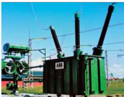
9 Transformador rectificador enfriado por aire con una potencia de 91,74 MVA
