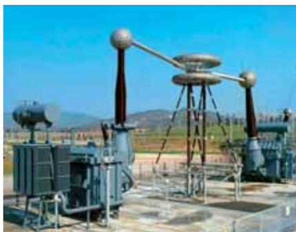
**5** Uno de los seis transformadores para convertidores instalados en el extremo receptor de la transmisión Pacific Intertie que abastece a Los Angeles
