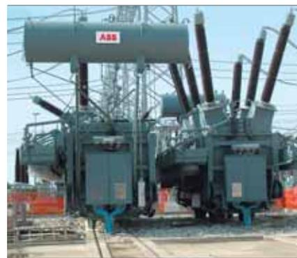
**7** Inductance (1923) pour la régulation de puissance et la protection contre les courts-circuits
