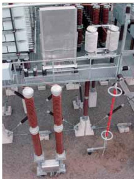
conditions climatiques réelles, sous contrôle d'ABB et d'Hydro-Québec. Ce n'est qu'à un stade ultérieur qu'elle remplaça la solution par éclateurs pour assurer la protection des condensateurs en étant couplée à la MOV originale.
