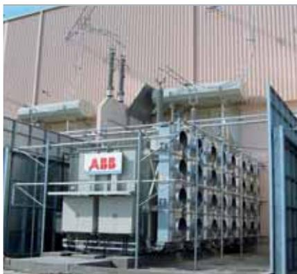
à la dernière version s'est accompagné d'une réduction de la masse sèche totale de 25 % et d'une diminution des pertes à vide et en charge d'environ 20 %. Après quoi, le client commença à acquérir et à installer des transformateurs auto-connectés, aux caractéristiques par ailleurs identiques.
