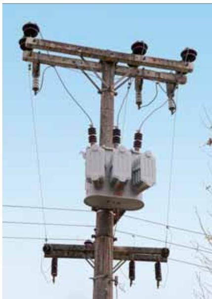
tous les maillons du transport électrique, de la centrale aux abonnés. En bout de chaîne, les «transformateurs de distribution» sont prévus pour s'adapter à la topologie du réseau de chaque région du globe 10.
