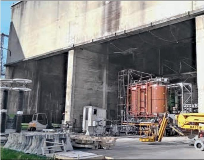
spannung ist zwischen 11,95 kV und 13,8 kV umschaltbar. Die Transformatorspulen sind vakuumvergossen, was die Robustheit der Wicklungen erhöht (Umweltklasse E2) und einen guten Schutz gegen Umweltverschmutzung und Feuchtigkeit bietet. Der Transformator wird durch natürliche Konvektion gekühlt und ist für eine Blitzstoßspannung von 350 kV getestet.
