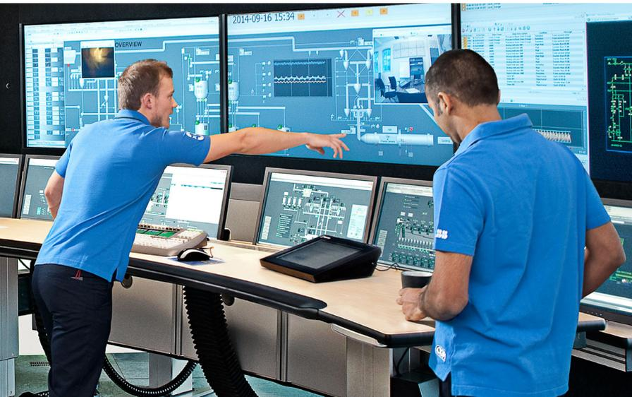
800xA PC, Network und Software Monitoring stellt in einem Grafikbild sicherheitsrelevante Statusinformationen von System- und Netzwerkkomponenten auf einen Blick dar und signalisiert Abweichungen im Automatisierungssystem.
