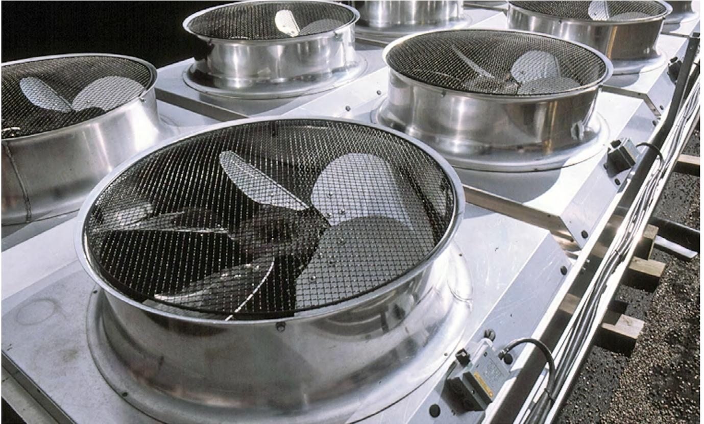
Der Einsatz von Frequenzumrichtern zur Regelung von Kondensatorlüftern kann die Effizienz um bis zu 15 Prozent erhöhen.
