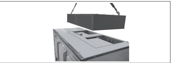
2. Lift fan unit onto the air channel.
