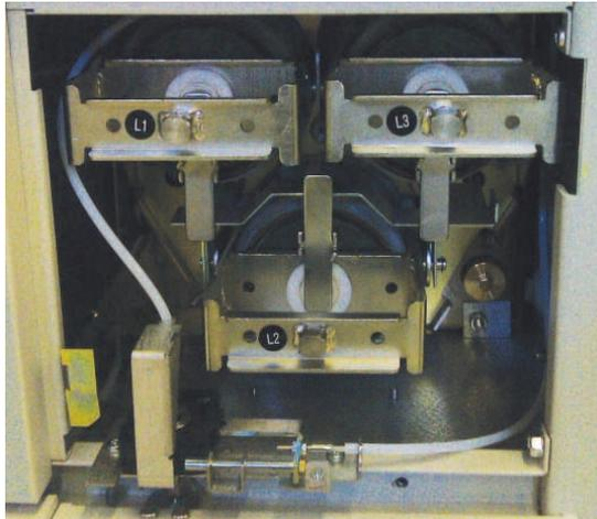
SafeRing提供了两种变压器保护方式：负荷开关熔断器组合电器和具有继电器保护的断路器。
