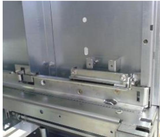
Previene l'inserimento dell'int. in caso di connettore multi-polare disconnesso
