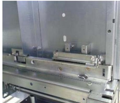
Empêchent l'insertion du disjoncteur si connecteur multipolaire déconnecté
