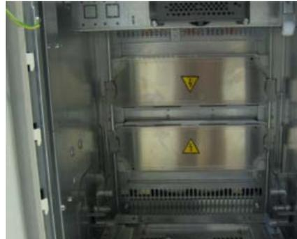
Volets isolés entre le compartiment du disjoncteur, le compartiment des barres omnibus et le compartiment des câbles pouvant être verrouillés à l'aide de cadenas en position ouverte et fermée :
