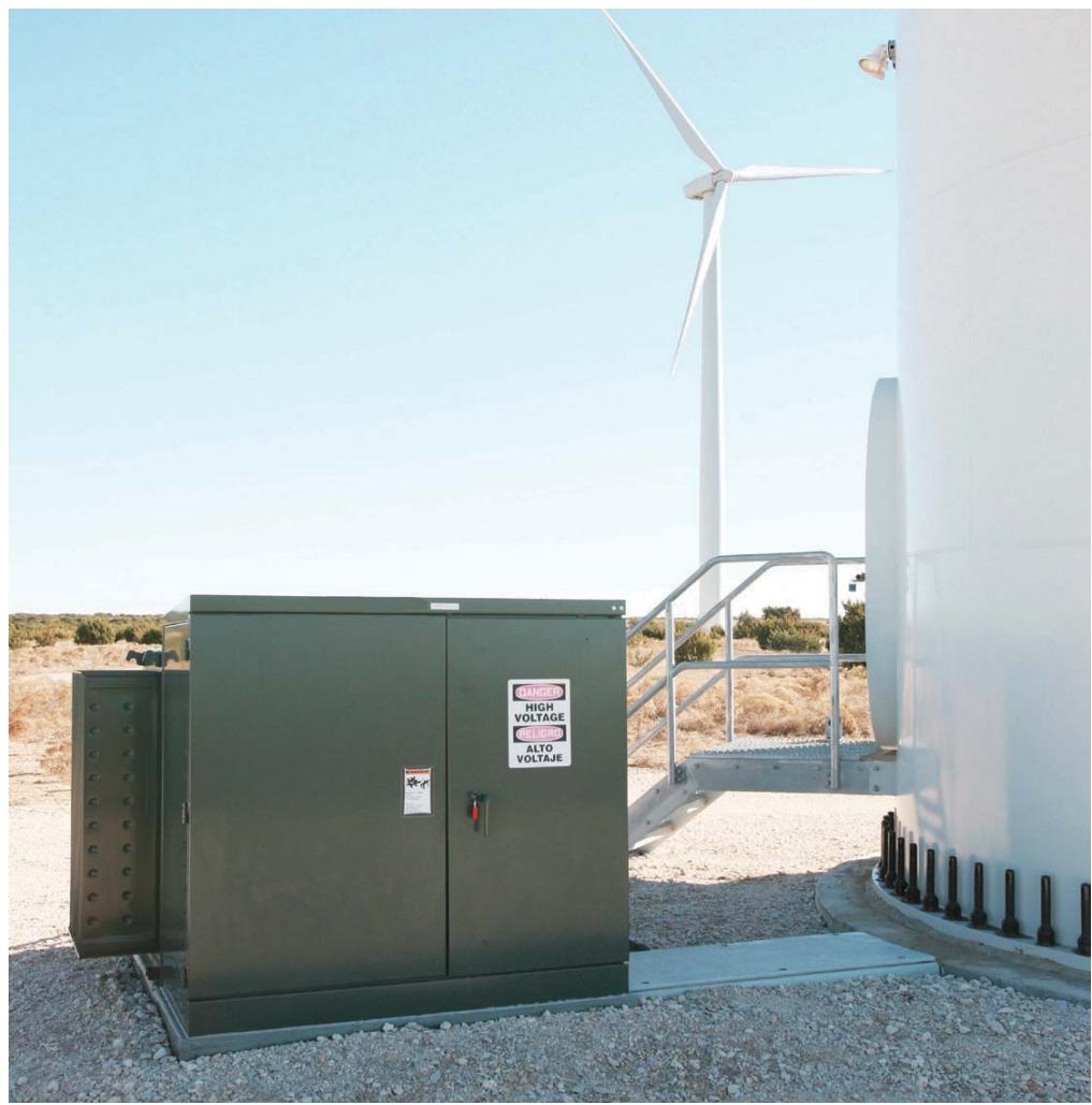
风力发电机并网变压器图
