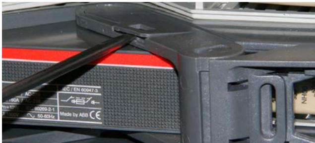
Betjenings håndtakene på XR'ene over og under kan utløses med en skrutrekker og flyttes til fri-posisjon og bryterene er fremdeles i PÅ posisjon.
