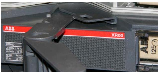
Med drifts håndtakene over og under i fri-posisjon, er det lett tilgang til L1 sikringen på XR i midten.
