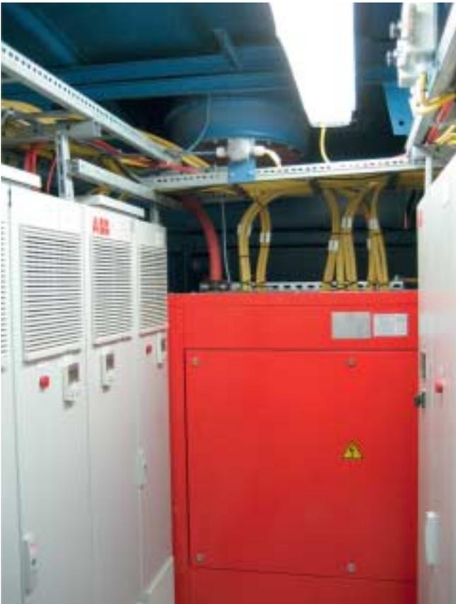
5 Electrical equipment room with switchgear cubicles and transformer E-Raum mit Stromrichterschrank und Transformator
