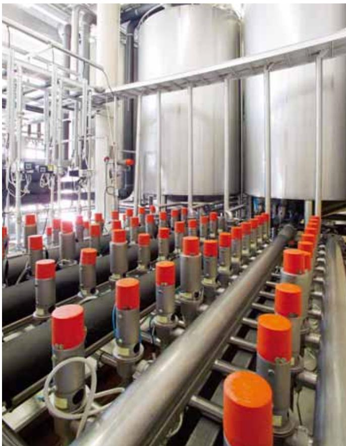
Las soluciones de limpieza CIP circulan por las tuberías gracias a bombas de lavado de presión centrífuga cuya velocidad se regula por medio de convertidores de frecuencia para maquinaria general de ABB.
