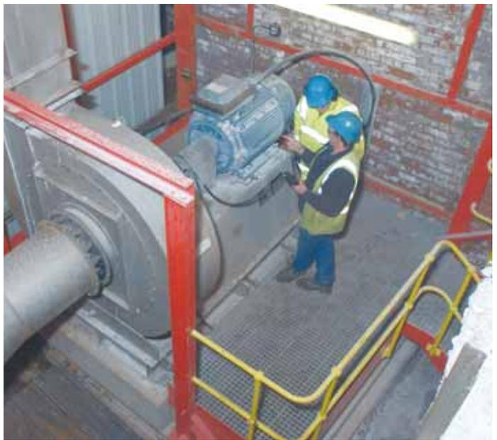
El nuevo motor de 132 kW, acoplado a un convertidor de frecuencia industrial de ABB, ahorra más de 1,6 GW/h anuales en comparación con el antiguo motor de 337 kW.
