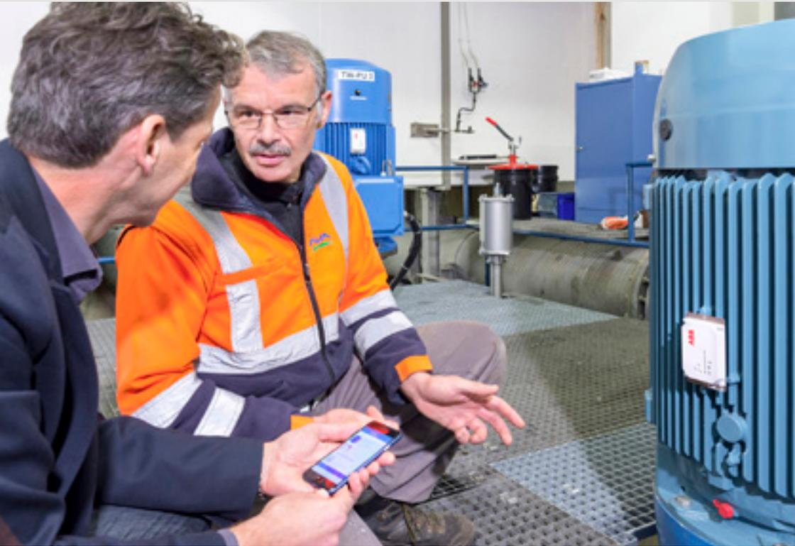
Capteur intelligent ABB Ability pour machines tournantes
