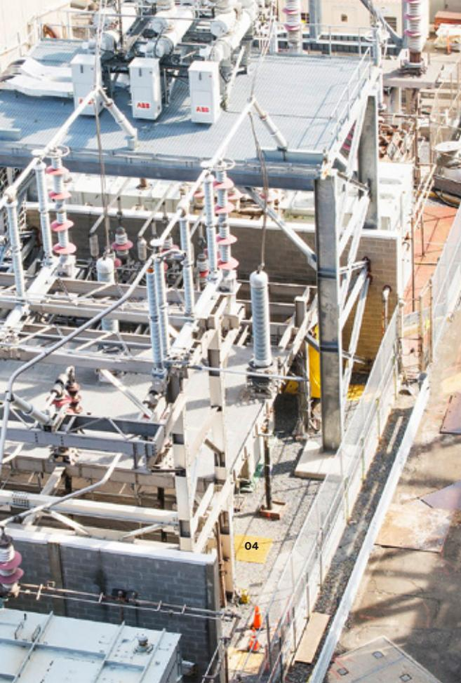
02 Das Umspannwerk von Con Edison in Lower Manhattan. Einige der neuen Schutzmaßnahmen wie die verstärkten Außenwände sind deutlich zu sehen.
