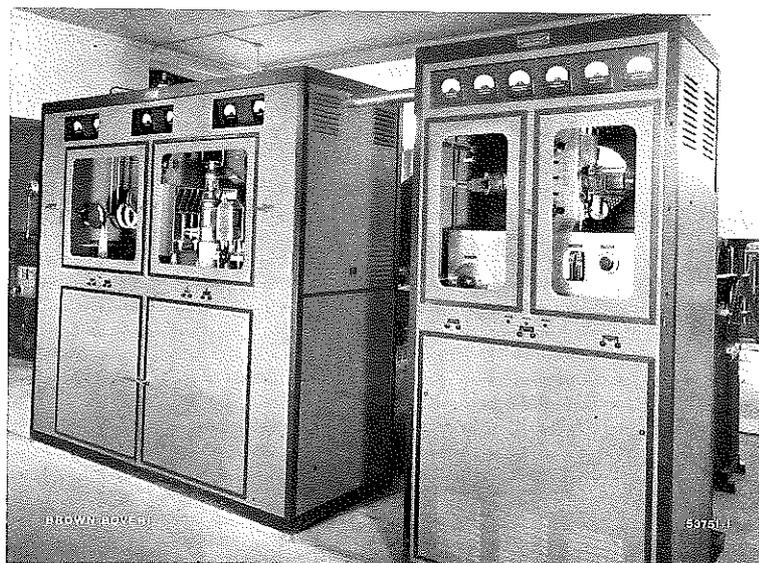
Abb. 12. — Hochfrequenzvorstufen (rechts) und Hochfrequenzendstufe (links). Im Innern des Schrankes links sind eine demontierbare Brown Boveri-Senderöhre sowie Teile des Anodenschwingkreises zu erblicken.
