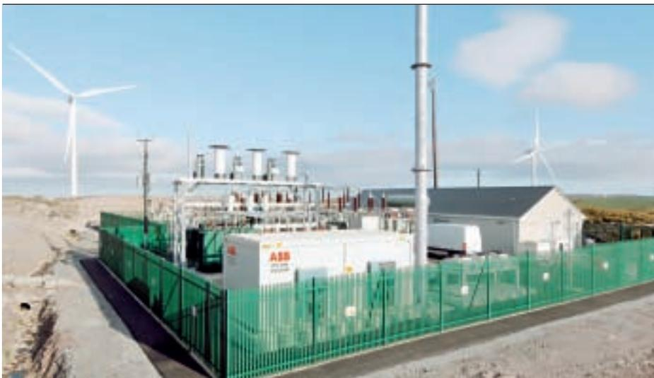
Court está conectado al secundario del transformador de 110 kV/ 33 kV del parque. Aquí el STATCOM estabiliza la tensión local del parque eólico creando una caída de tensión a través del transformador. Sin embargo, en función de las necesidades de los clientes o del código de red, el STATCOM se podría haber conectado directamente al nivel de transporte en el primario del transformador principal del parque eólico.
