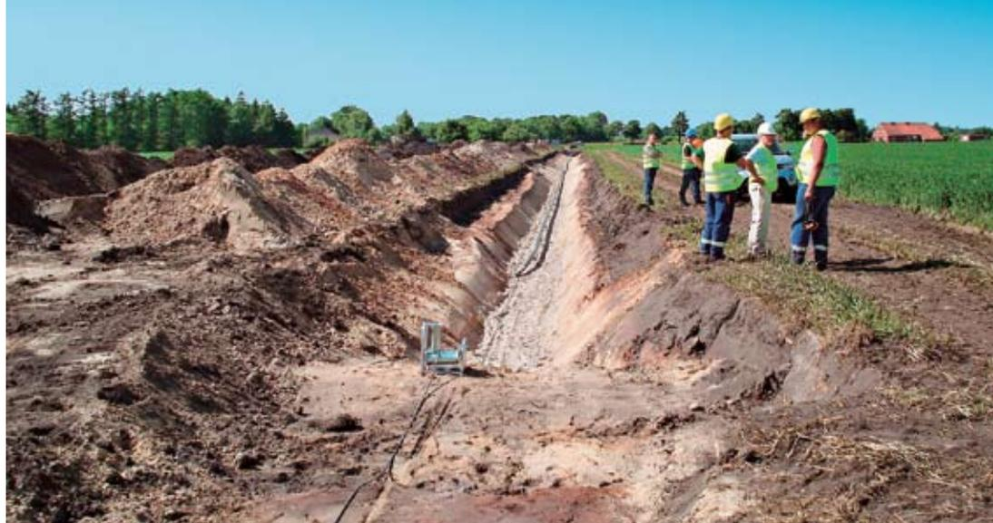
4 Posizione dei primi tratti di cavo (tensione di esercizio di 150 kV, capacità di trasmissione di 400 MW) nella contea di Aurich, in Germania nel giugno 2008.
