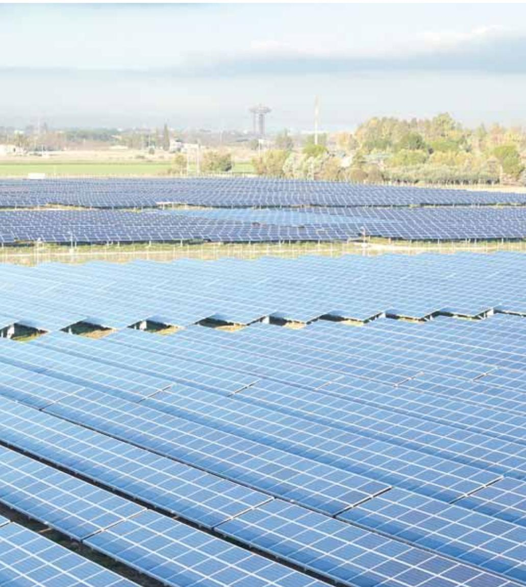
Campo fotovoltaico De Nittis, Foggia - 39 MW installati su tre impianti a pannelli fissi.
