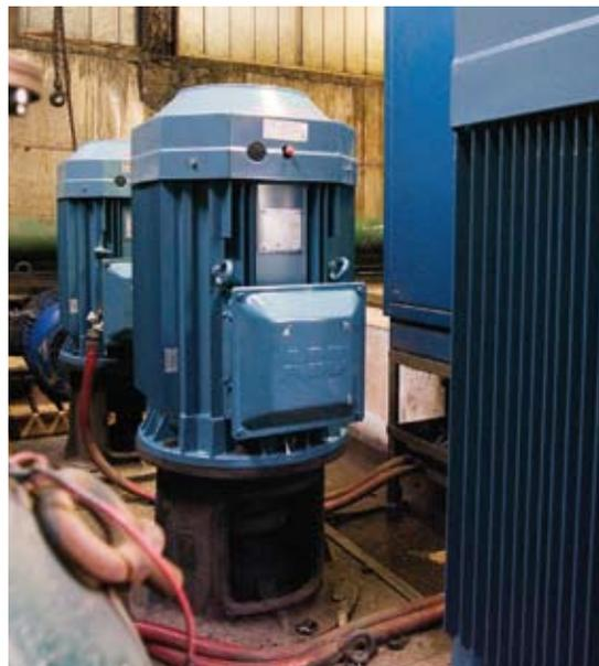
L'installazione dei primi Inverter e di motori EFF1 assicura alla fabbrica Iveco una riduzione dei consumi annui di energia elettrica. Per cortesia di Iveco.
