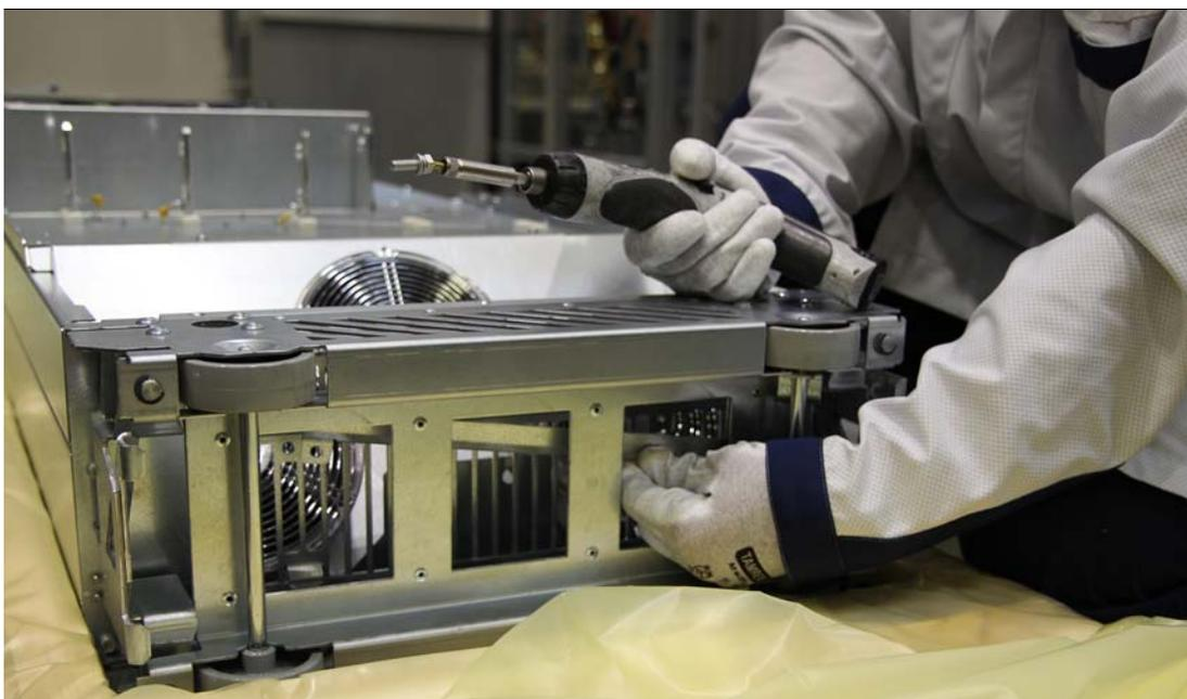
Insérez les crochets de levage dans les anneaux du module variateur et soulevez-le pour le déposer sur le site d'installation.
