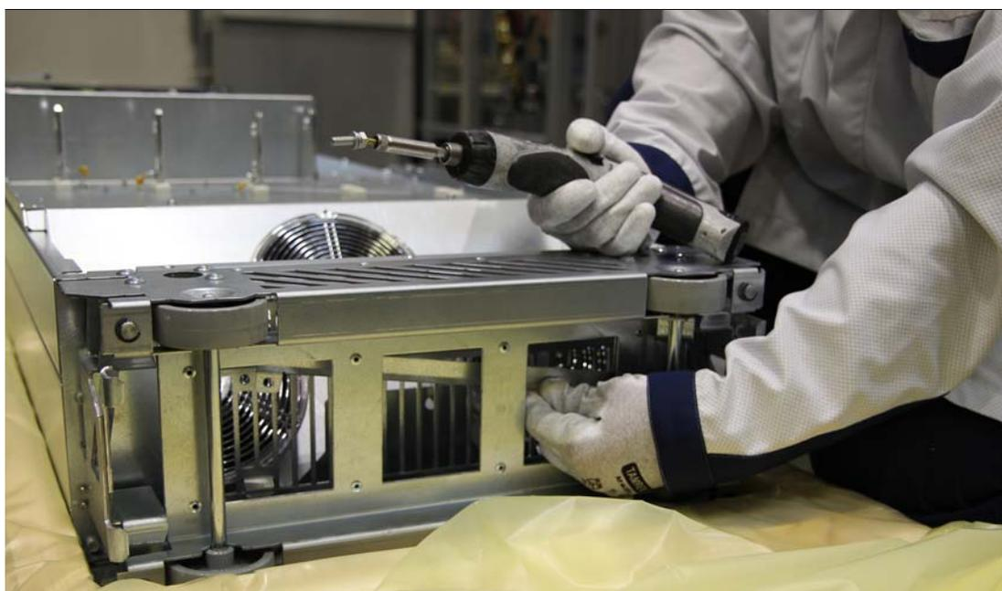
Introduzca ganchos de elevación en los cáncamos de elevación del módulo de convertidor y levante el módulo hasta el lugar de instalación.
