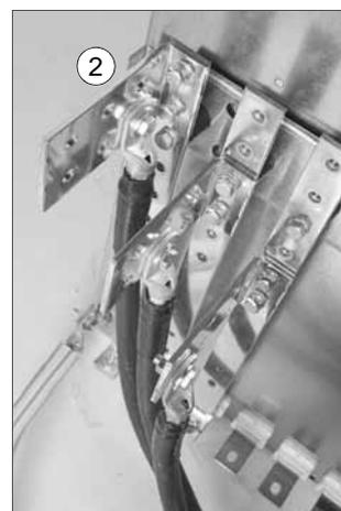
Se recomienda la puesta tierra en 360° de la pantalla del cable de motor a la entrada del cable en el armario (véase la página [41](#)).
