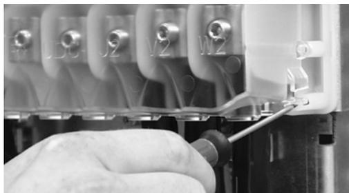
2. Collegare le schermature intrecciate dei cavi di alimentazione ai morsetti di terra del modulo convertitore.
