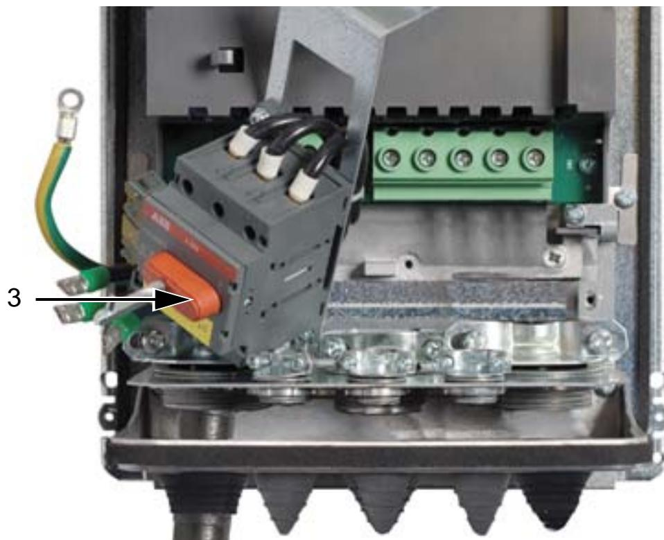
4. Retirez les passe-câbles en caoutchouc et découpez-y des trous de diamètre adéquat. Enfilez les passe-câbles sur les câbles de puissance en veillant à diriger la partie conique vers le bas. Fixez hermétiquement les passe-câbles aux perçages de la plaque passe-câbles.
